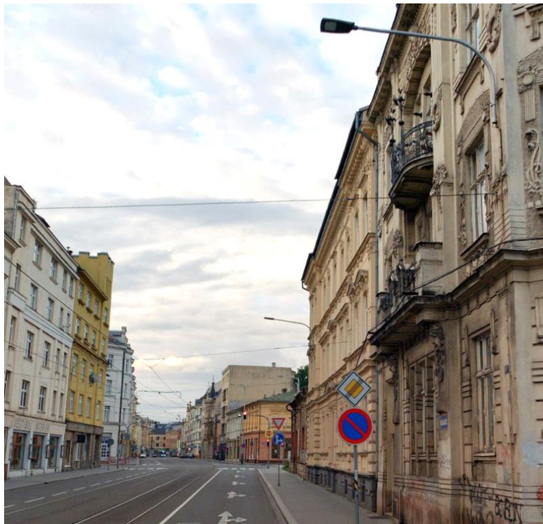
Obr.3 (Stávající stav - ul. Nádražní, VO na historických budovách)
