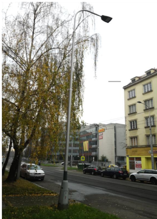
Obr.4 (Stávající stav - ul. Nádražní, VO na ocelových stožárech)
