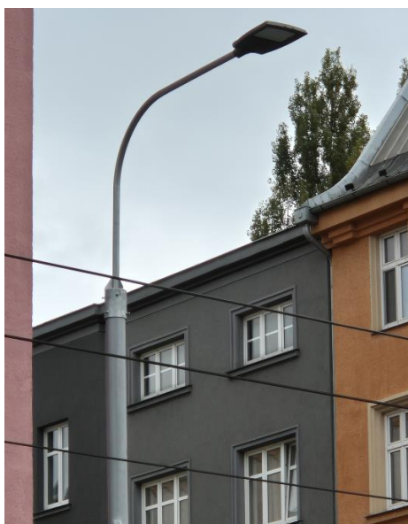
Obr.7 (Nový stav – ul. Nádražní, VO na trakčním stožáru)
