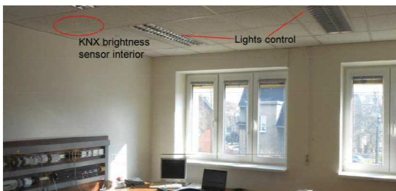
Obr. 3. Rozmístění zářivkových svítidel a snímače osvětlení KNX v kanceláři TRIMR
