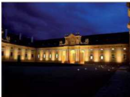
Obrázek 2 – Noční osvětlení průčelí zámecké jízdárny
