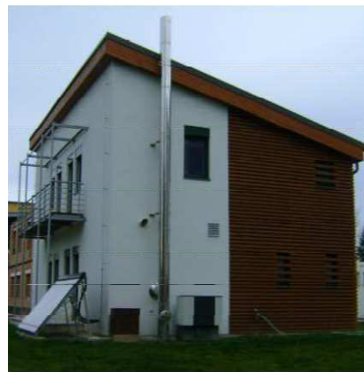
Obr. 2. Dřevodomek s implementovanou technologií KNX pro řízení osvětlení a žaluzií.
