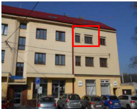
Obr. 1. Laboratoř, referenční místnost a umístění meteorostanice pro řízení osvětlení ve firemní kanceláři - pohled z venku.
