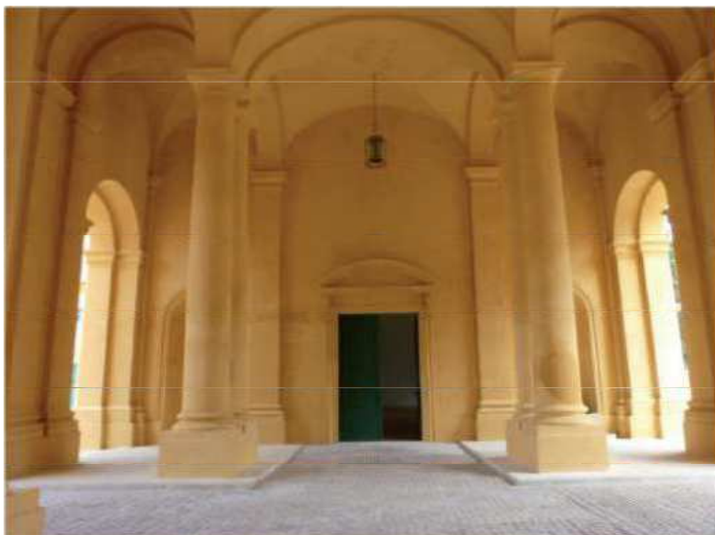
Obrázek 5 - Jižní průjezd zámecké jízdárny s lucernou
