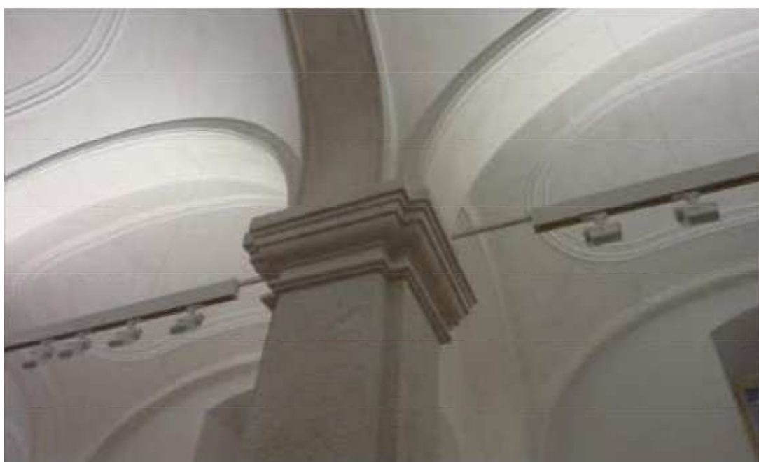
Obrázek 3 – Upevnění a napojení svítidel Kvadra 106
