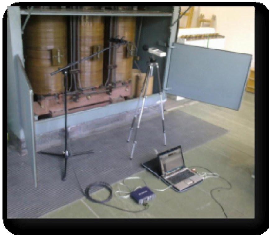
• obr. 3 Měření hlukových emisí transformátoru
