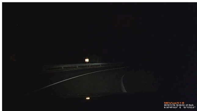
Obr.18 Špatná orientace a vedení v oblouku komunikace
